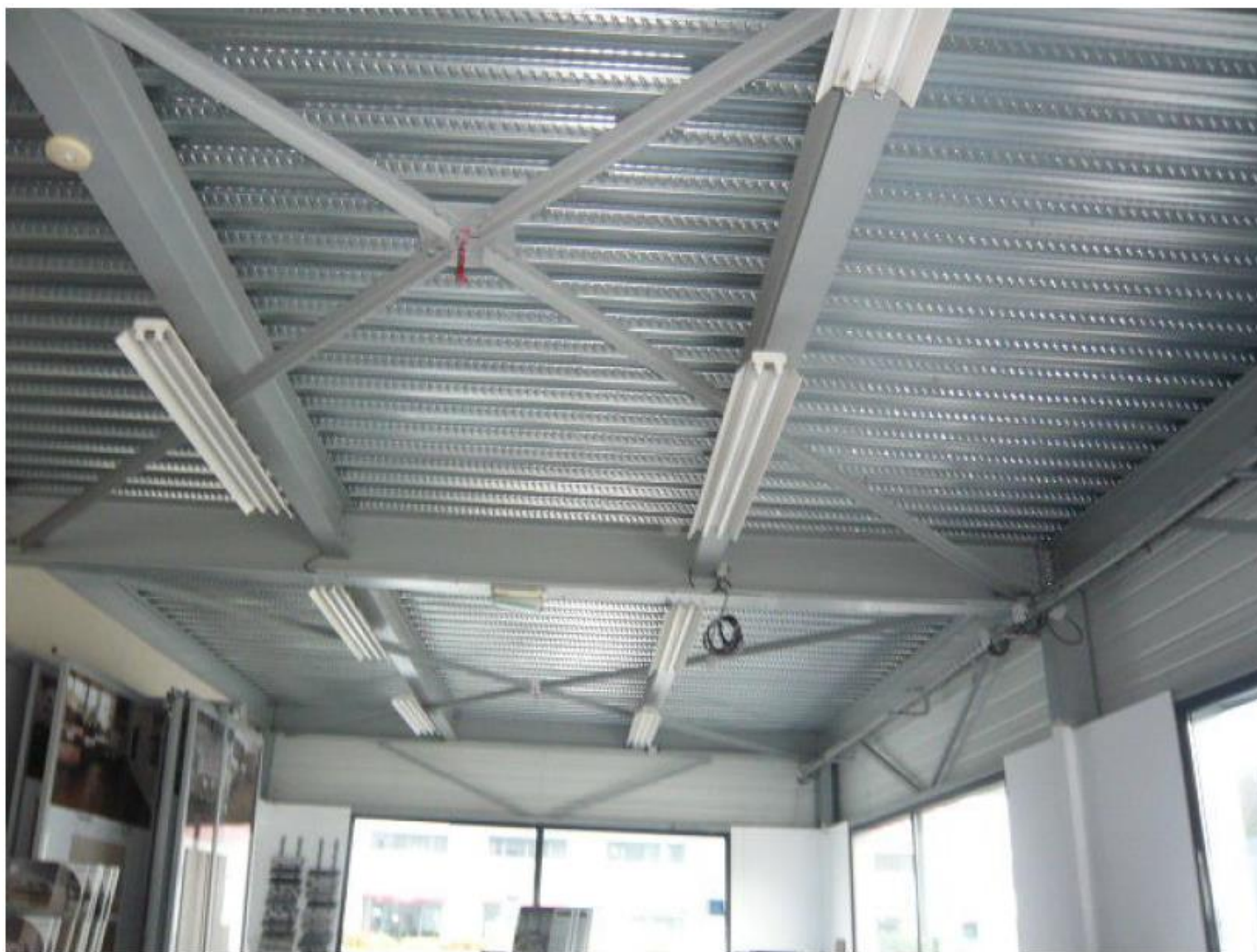
Couverture du local
